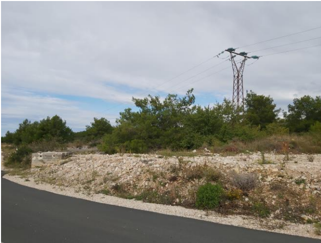
Pogled na zonu u obuhvatu Plana s dijelom izvedene nerazvrstane prometnice Ulice Učiteljice Karmele Pelicarić Marušić , i pogledom na zračni 35 kV dalekovod.
